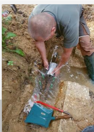
Pose du manchon d'étanchéité
